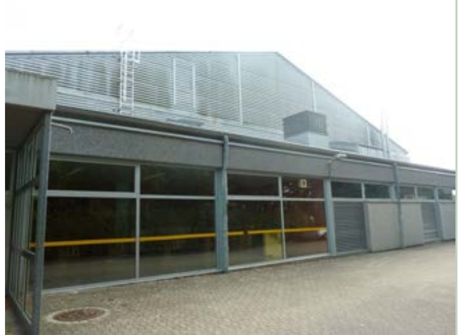
Gymnase raccordé à la chaudière
