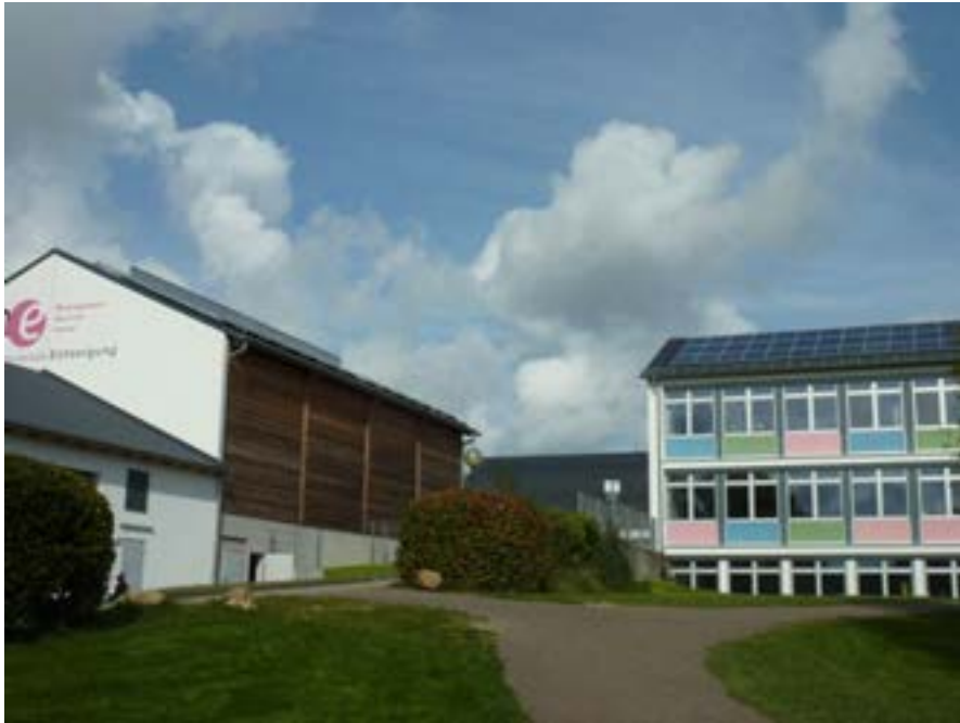
Chaudière et école raccordée
